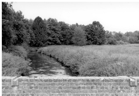
Rustbank op brugmuur
