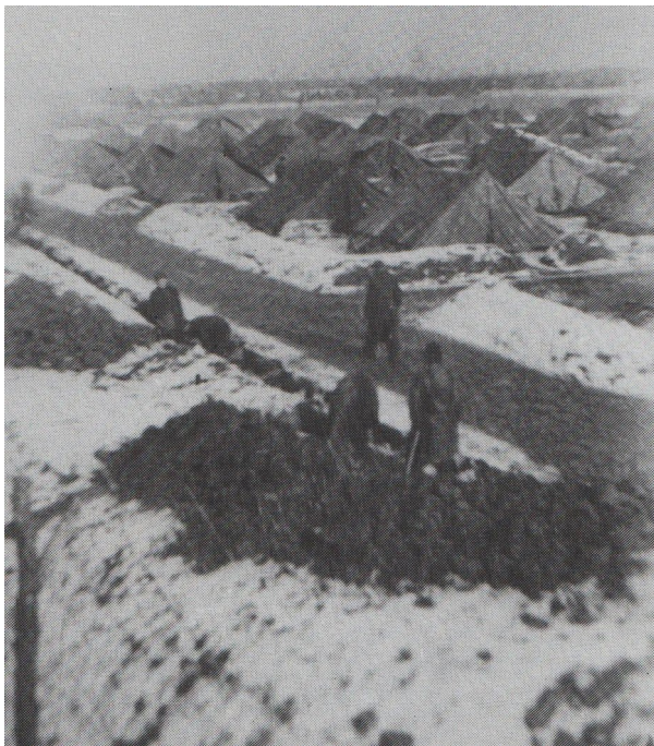
[27] Travaux de réparation en cours pendant l'hiver
